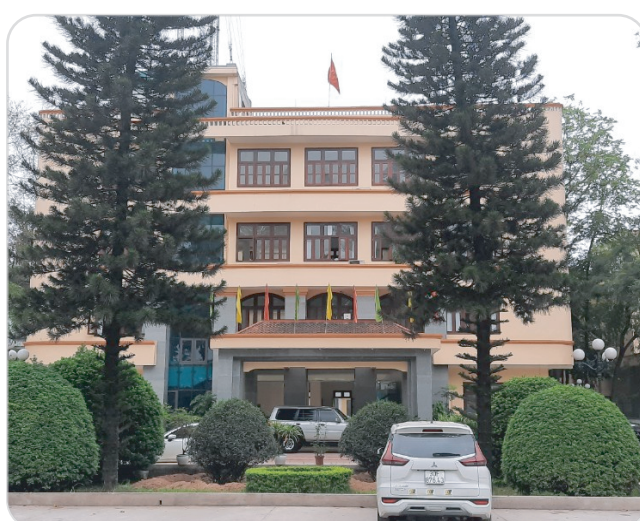
Viện khoa học lâm nghiệp Việt Nam Hạng mục thi công: Vách ngăn vệ sinh
