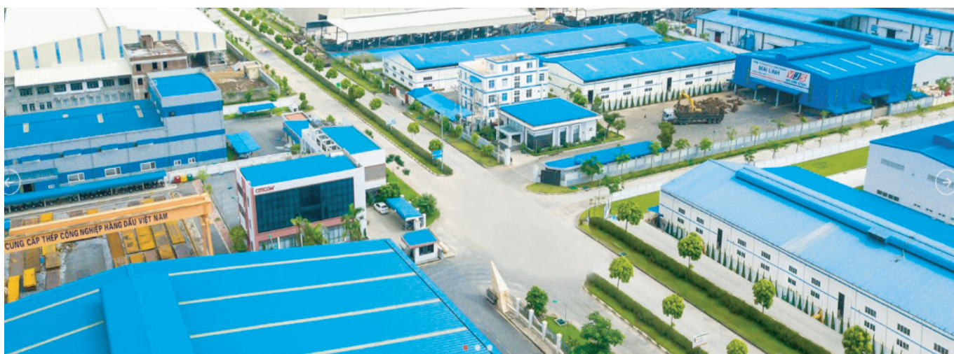
Nhà máy cắt xẻ thép Hải Phòng Hạng mục thi công: Vách ngăn vệ sinh
