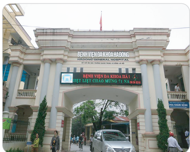
Bệnh viện đa khoa Hà Đông Hạng mục thi công: Vách ngăn vệ sinh
