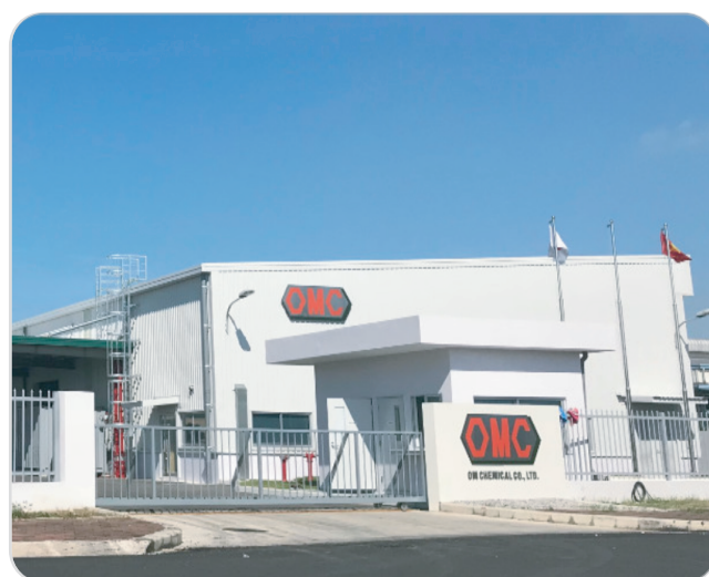
Nhà máy OM Chemical Hạng mục thi công: Vách ngăn vệ sinh
